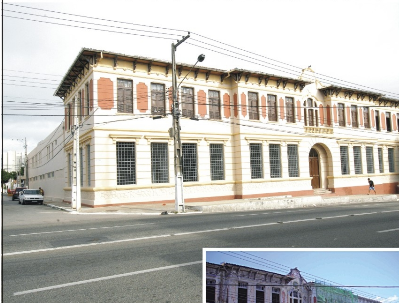
Prédio após restauração concluída (setembro/2009)
