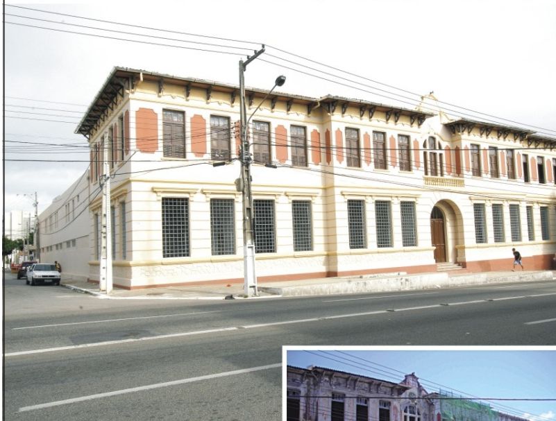
Prédio após restauração concluída (setembro/2009)
